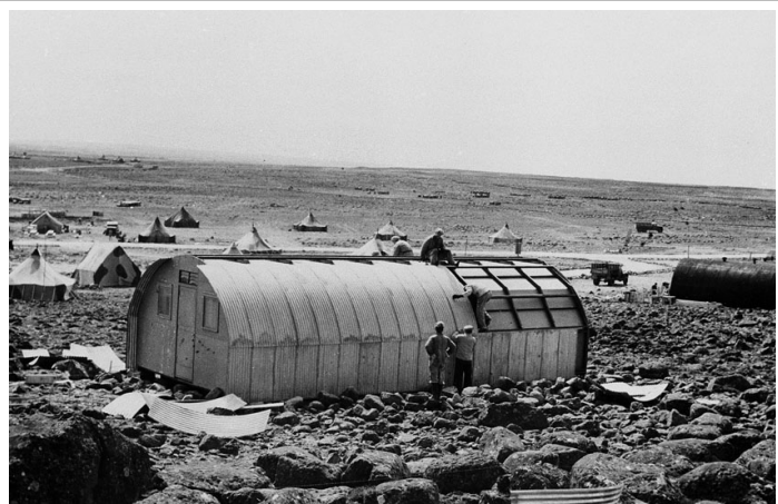
Íslendingar við braggasmíði á Pattersonflugvelli sumarið 1942. Þrjár u.þ.b. 1,5 km langar flugbrautir voru lagðar í slakkanum handan við braggann.
